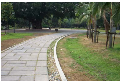
圖 19 自行車道或人行步道以透水性鋪面側溝採淺草溝排水
