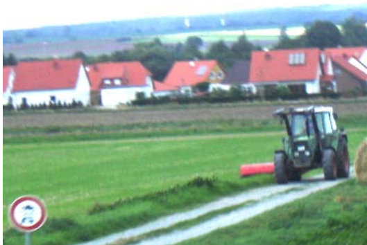
上圖 12 為德國農路現況，農路僅允許農業交通工具通行，故道路僅在車行軌道鋪設硬鋪面，農路規劃設計與管制措施相互配合（照片來源：本文實地拍攝）
