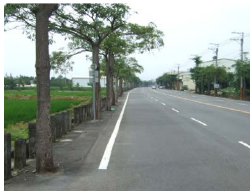
上圖 15 為台灣聚興村連外道路現況，車道過於寬敞，綠帶略顯不足。一些商家座落於路旁，衍生出許多交通問題（照片來源：本文實地拍攝）
