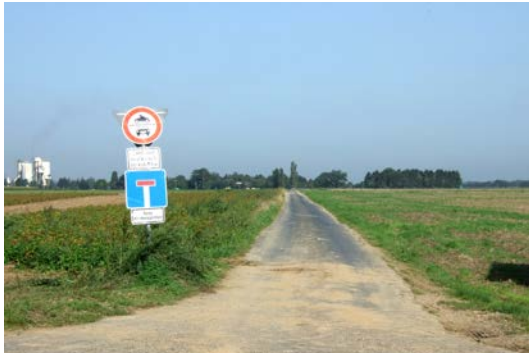
上圖 10 為德國農路現況，道路入口處設置標示牌，同時僅允許農業交通工具通行（照片來源：本文實地拍攝）
