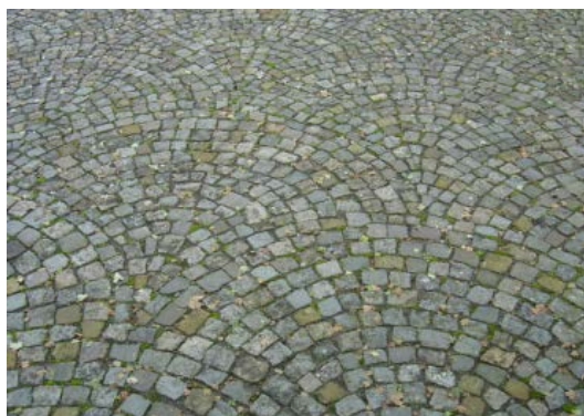
上圖 28 為德國農村道路常見的透水性鋪面，兼具生態與景觀功能（照片來源：本文實地拍攝）
