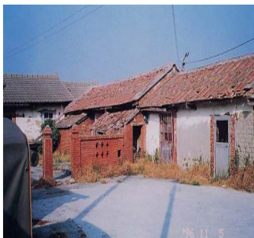
圖 20：南柳社區重劃前老舊房屋（一）
