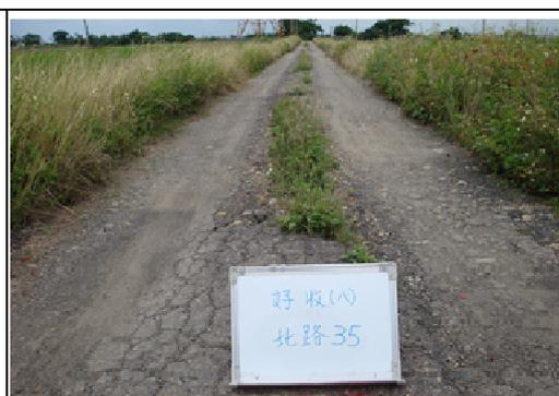
圖 2 改善前農路-老化龜裂 A.C. 路面
