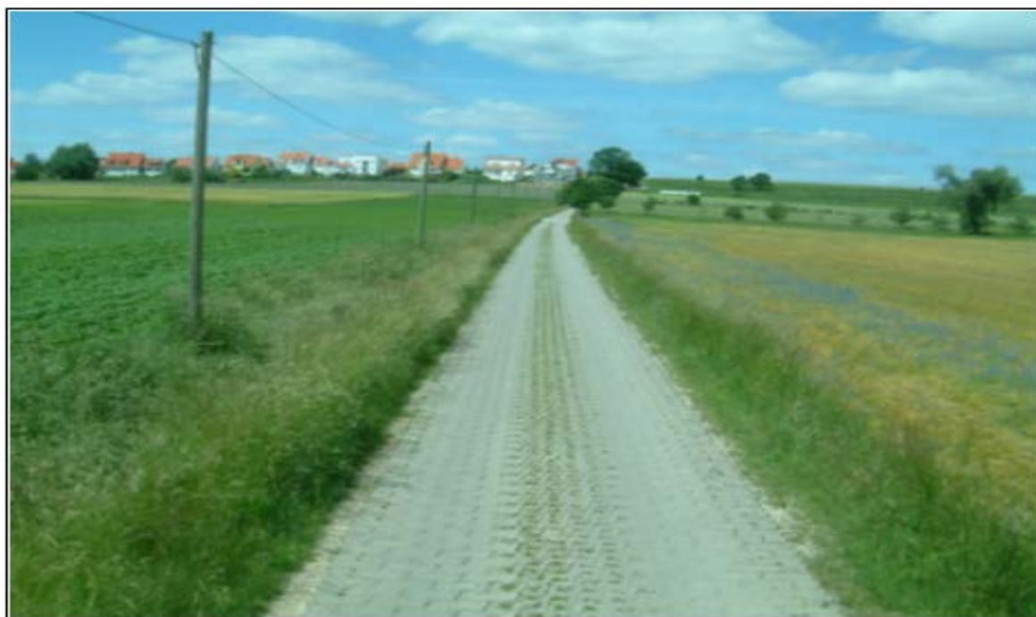
圖 4 農路採用不同樣式透水性鋪面設計，以減少地表沖刷、雨水流失以及增加鋪面透水性。
