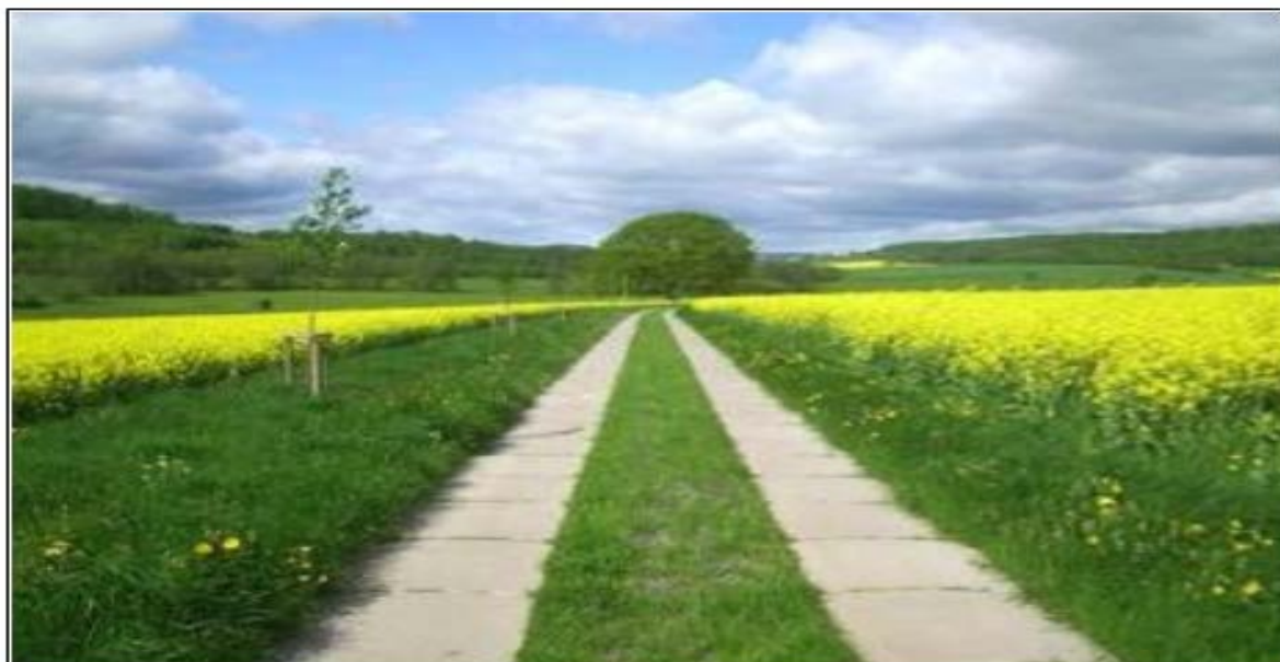
圖 3 農路除主要軌道採硬鋪面以利運輸外，其餘均鋪設自然鋪面，兼顧美觀及生態效益。
