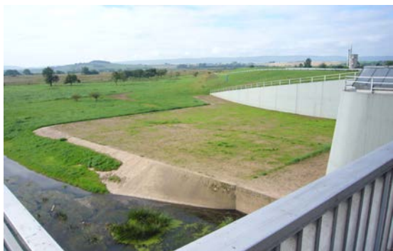
圖 15 水閘門外的河堤(本研究拍攝)
