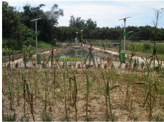
圖 3 表面下濕地(下為礫石床)
