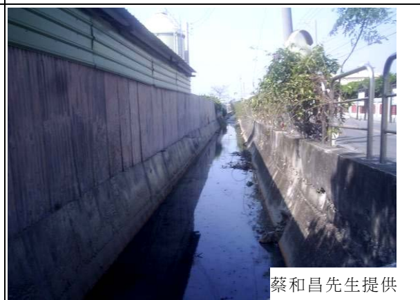
圖 20 永樂社區未經處理之污廢水流入大排
