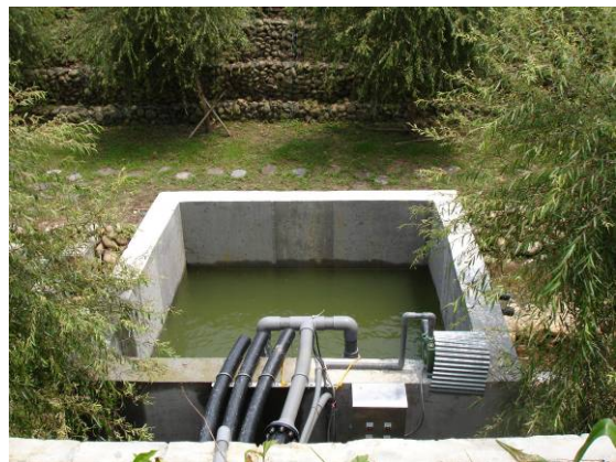
圖 5 人工濕地處理後截水槽收集
